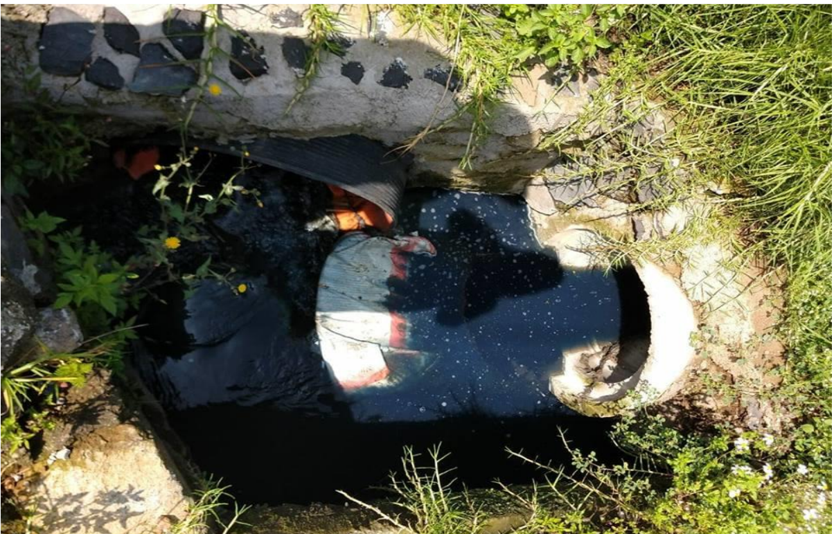
Fotografía N°6 Punto de descarga del municipio de Almoloya del Rio Abril 2018
